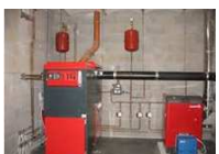
Chaudière à mazout (chauffage central d'une habitation)
